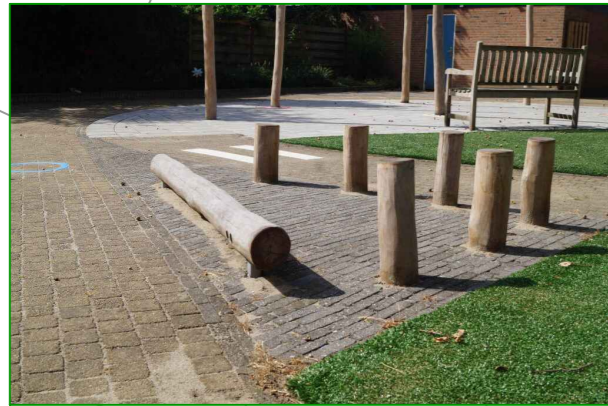
6) + 9) TE VERVANGEN STAPSTAMMEN
